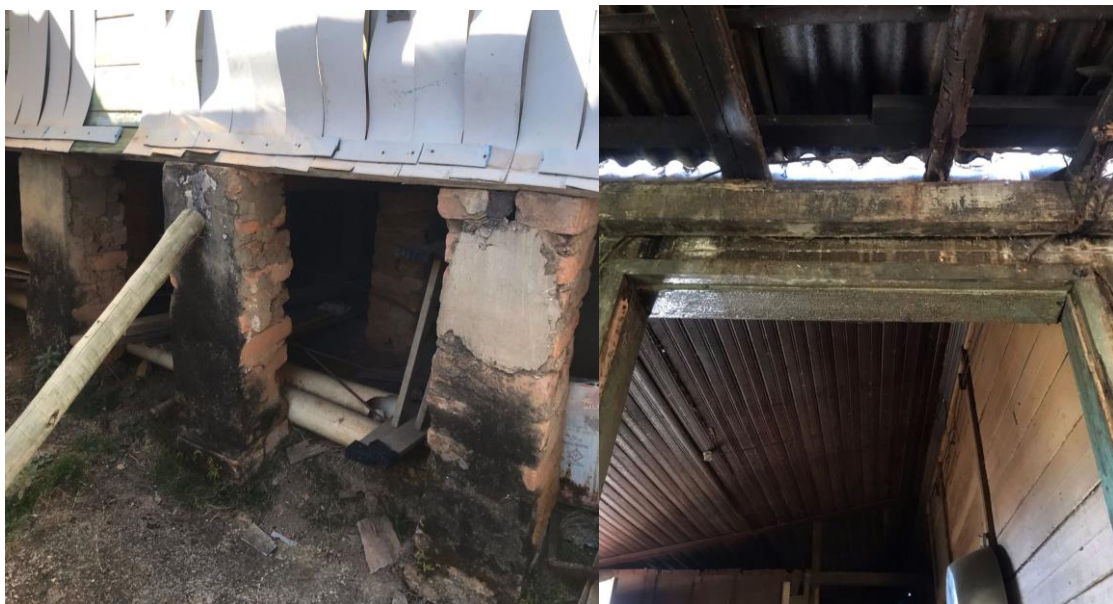
FIGURAS 12 e 13 - Estrutura casa de madeira.
