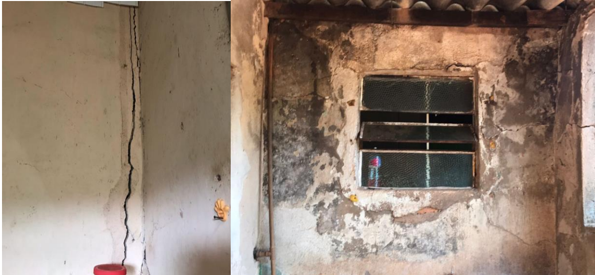
FIGURA 56 - Rachaduras (MB).
