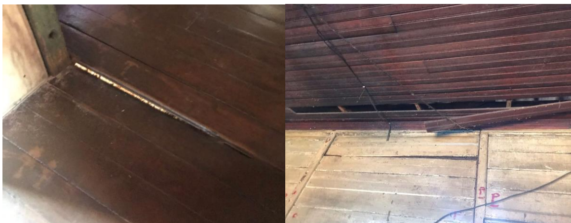
FIGURAS 14 e 15 - Estrutura casa de madeira.
