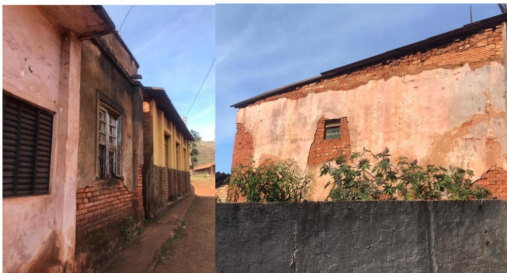
FIGURAS 34 e 35 - Fachadas de edificações na rua Antônio Gonçalves.
