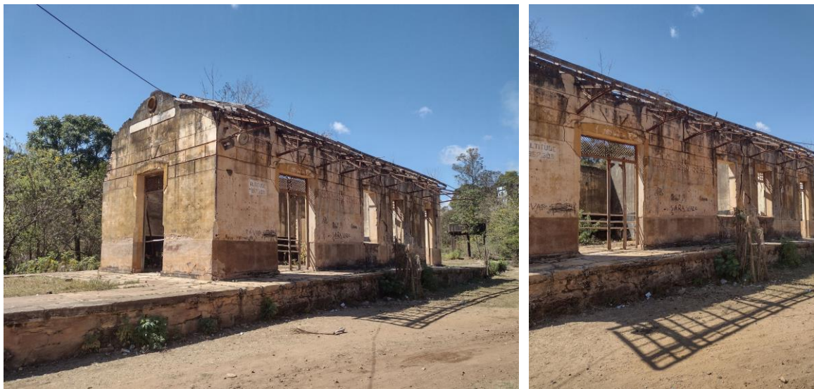
FIGURAS 08 e 09 – Estação Ferroviária de Engenheiro Corrêa.
