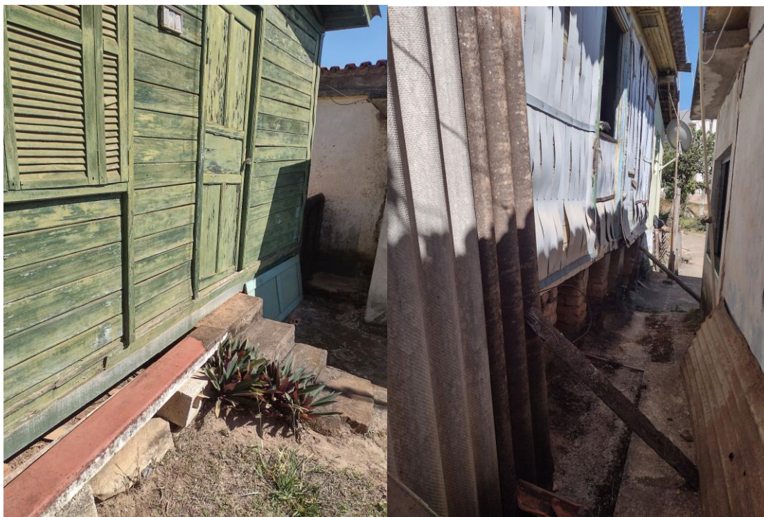
FIGURAS 10 e 11 - Estrutura casa de madeira.
