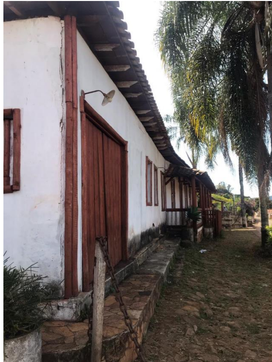
FIGURA 29 - Edificação na Rua Vereador Hélio Ferreira Pedrosa.
